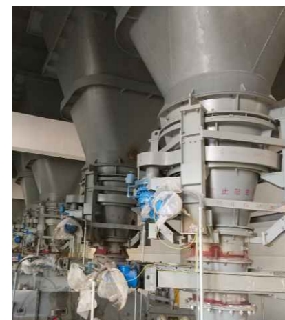
贞丰县煤电冶一体化工业园 热电联产动力车间（新建 项目）
